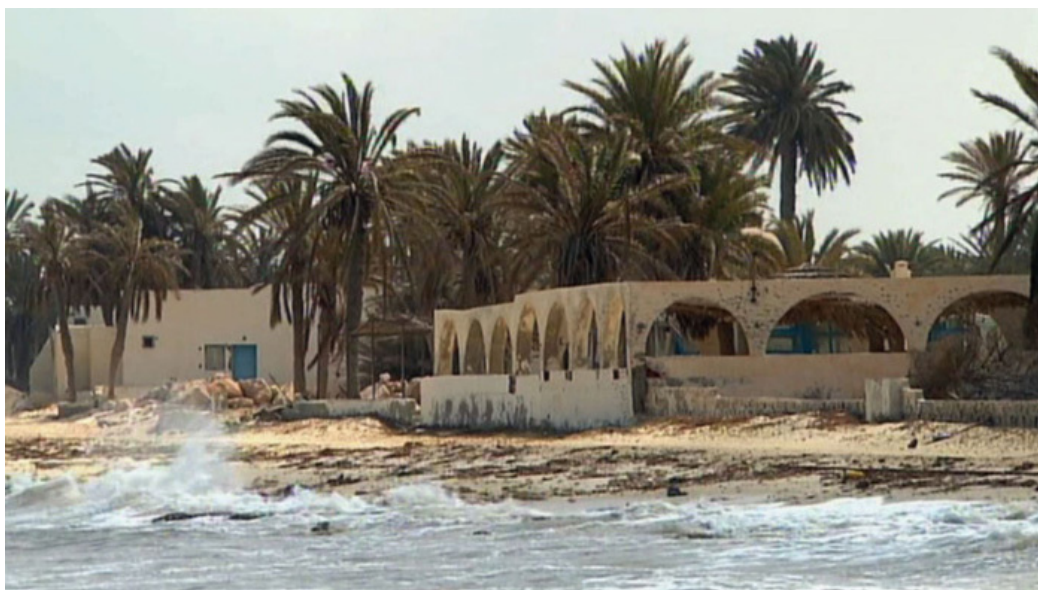
Figure 9 : Dégradation du littoral dans une zone touristique à Djerba
