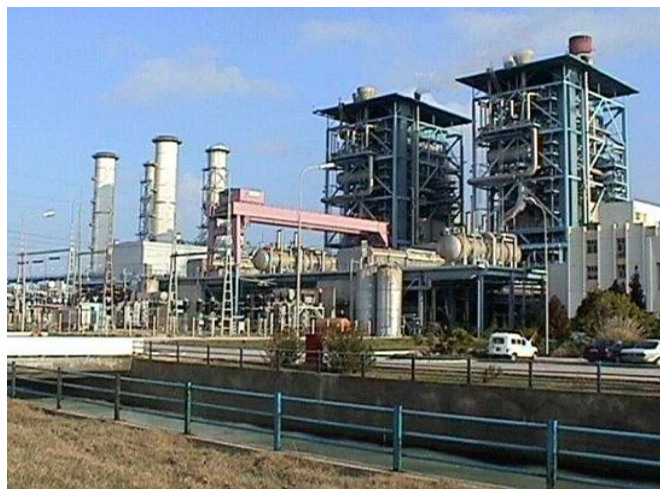
Figure 12 : Centrale électrique de Sousse
