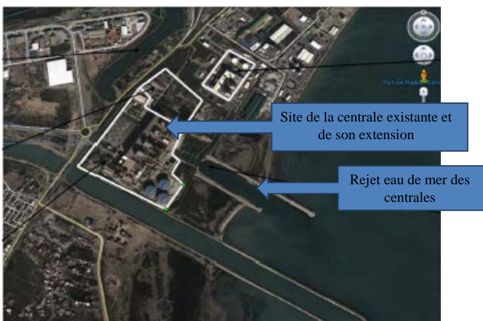
Figure 11 : Vue aérienne de la centrale de Rades
