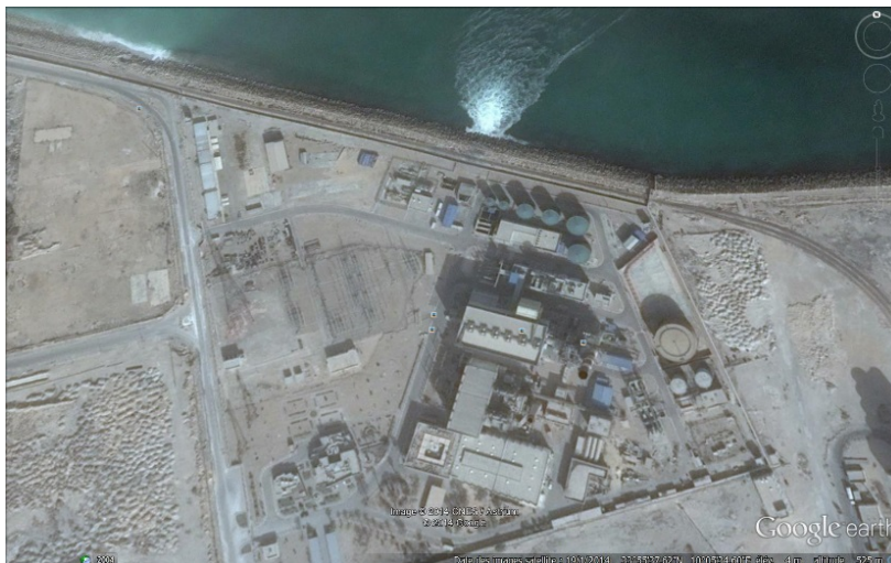
Figure 13 : Centrale électrique de Ghannouch à Gabes
