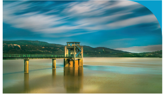
سدّ بني مطير (مياه سطحية)
